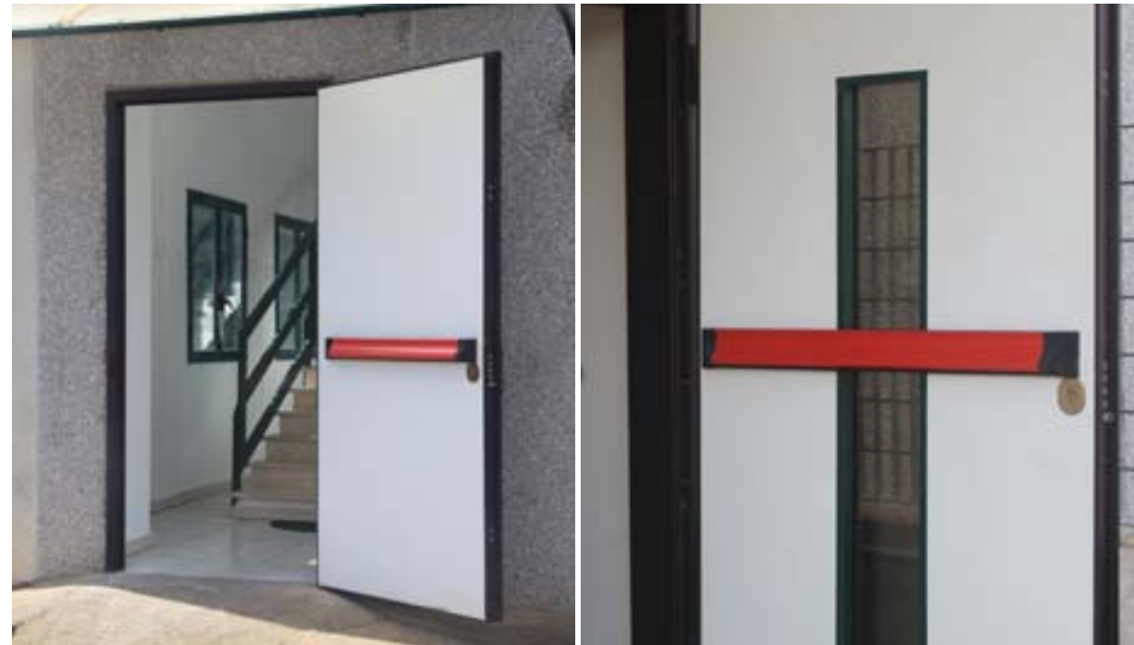
maniglione antipanico modello PUSH (serratura di sicurezza con sblocco mandate)
